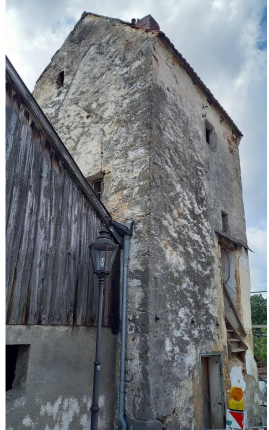
Ost- und Nordfassade 2023
