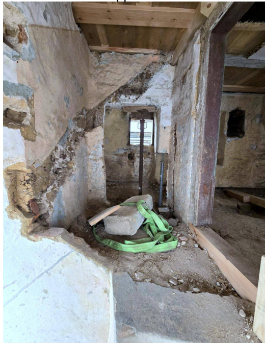
Nach Rückbau Treppe und Böden
