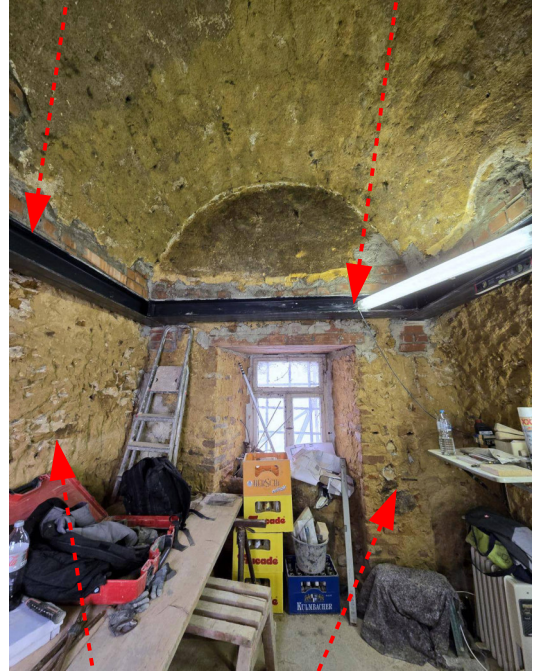
Wandputze des 20. Jhs. abgenommen
