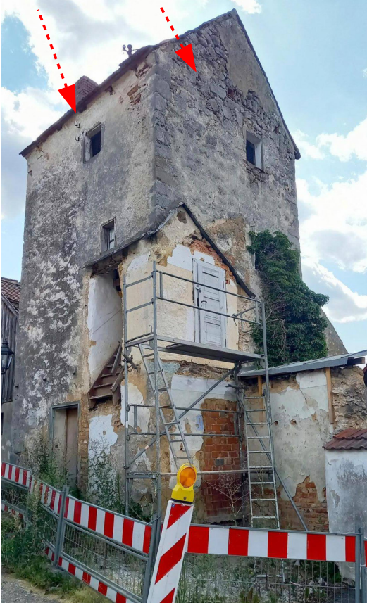
Nord- und Westfassade nach Rückbau Anbau 2023
