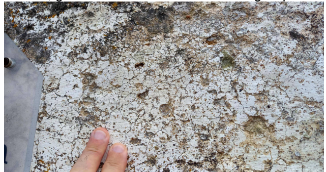
Weißer, glatter und leicht mitlaufender Originalputz
