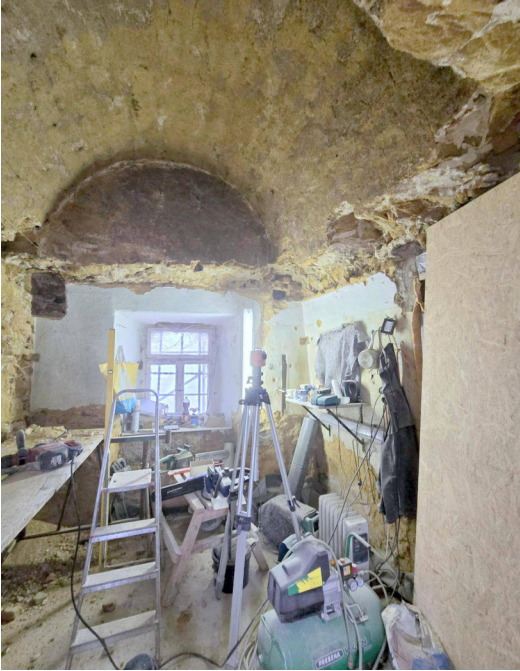
Bauzeitliches Gewölbe nach Rückbau Decke
