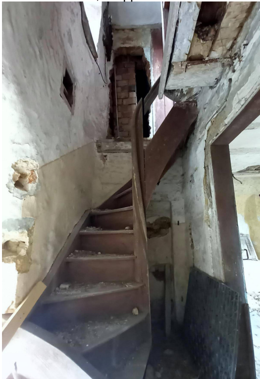
Flur nach Osten, Treppe ins 2. OG
