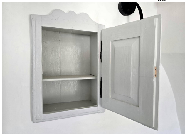
Bad Ostwand, Wandschrank mit Leinölanstrich fertiggestellt
