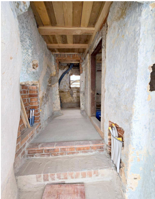
Bodenplatte und Decke neu, Wände gereinigt
