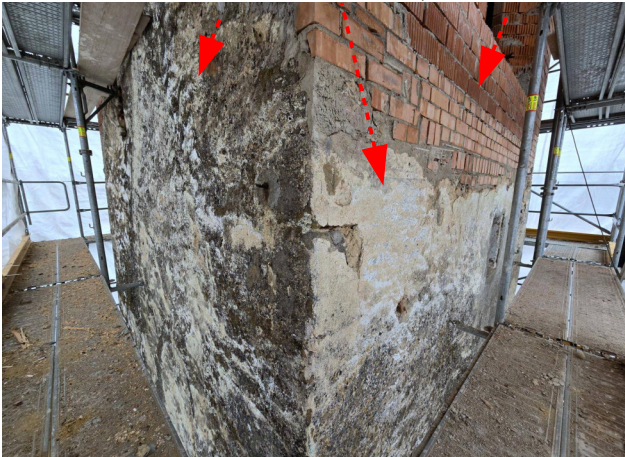
Ecksituation zur Ost- und Nordseite, Aufbau DG neu
