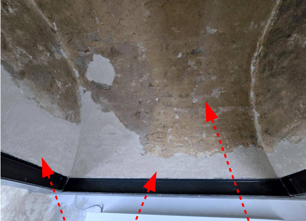
Putzergänzung vor der Retusche, historische Oberflächen wurden gereinigt und gefestigt
