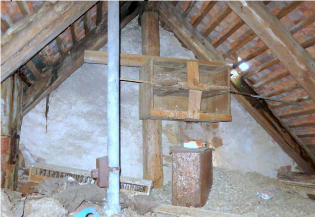
Spätmittelalterlicher Ostgiebel Vorzustand 2023
